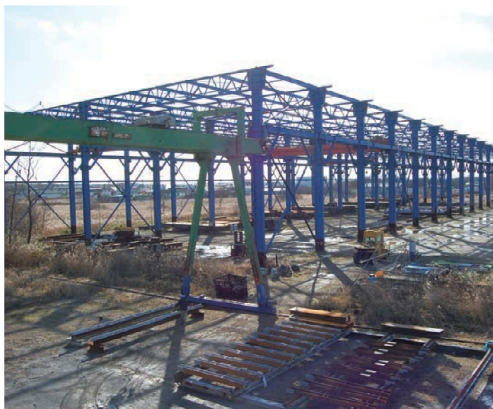
中沼ヤード全景
